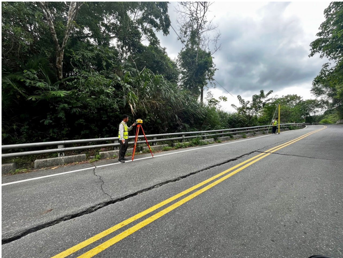
圖 11：精密水準測量工作情形，於跨斷層之柏油道路上進行，依內政部一等水準測量作業實施規範（內政部，2014）施作。
