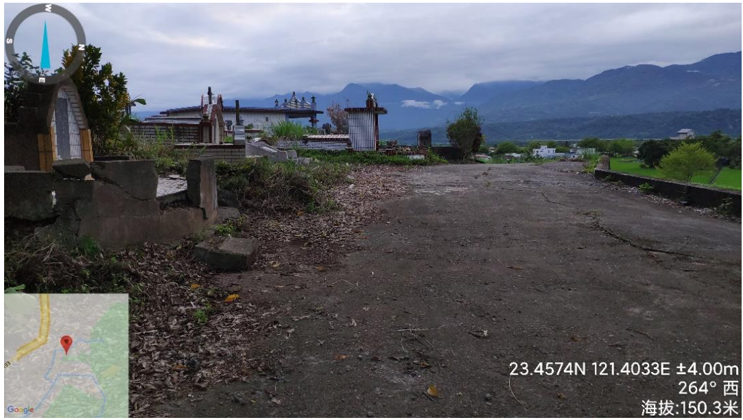
圖 22、春日地區奇美斷層線上，建物及地表部新生推擠破裂現象。
