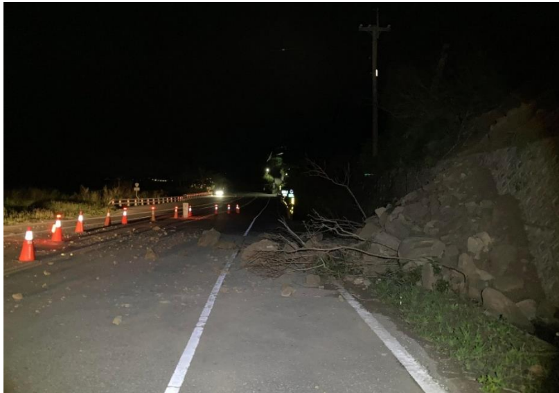
圖 29、玉長公路強烈地表加速度引之邊坡滑動（旺財應用地質技師事務所提供）。
