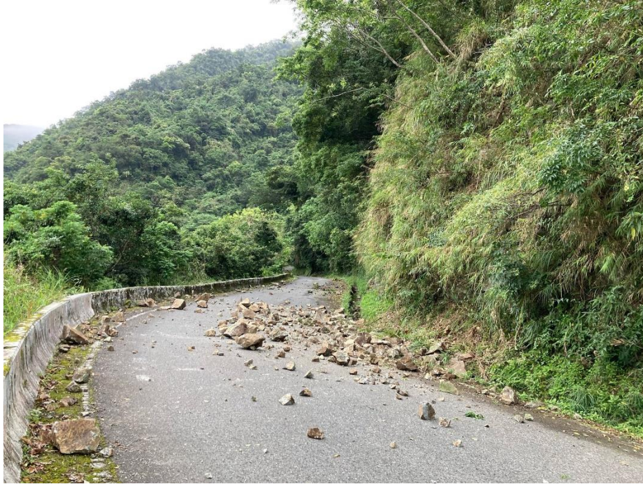
圖 30、瑞港公路強烈地表加速度引起邊坡落石（旺財應用地質技師事務所提供）。
