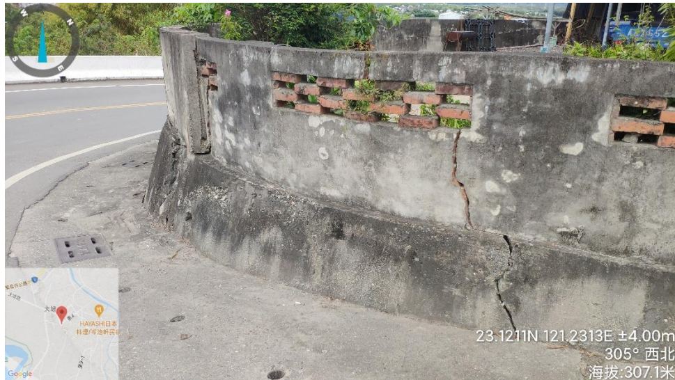
圖 18、池上斷層之上盤，部分區域可見到壓縮引起的地表局部破裂現象。
