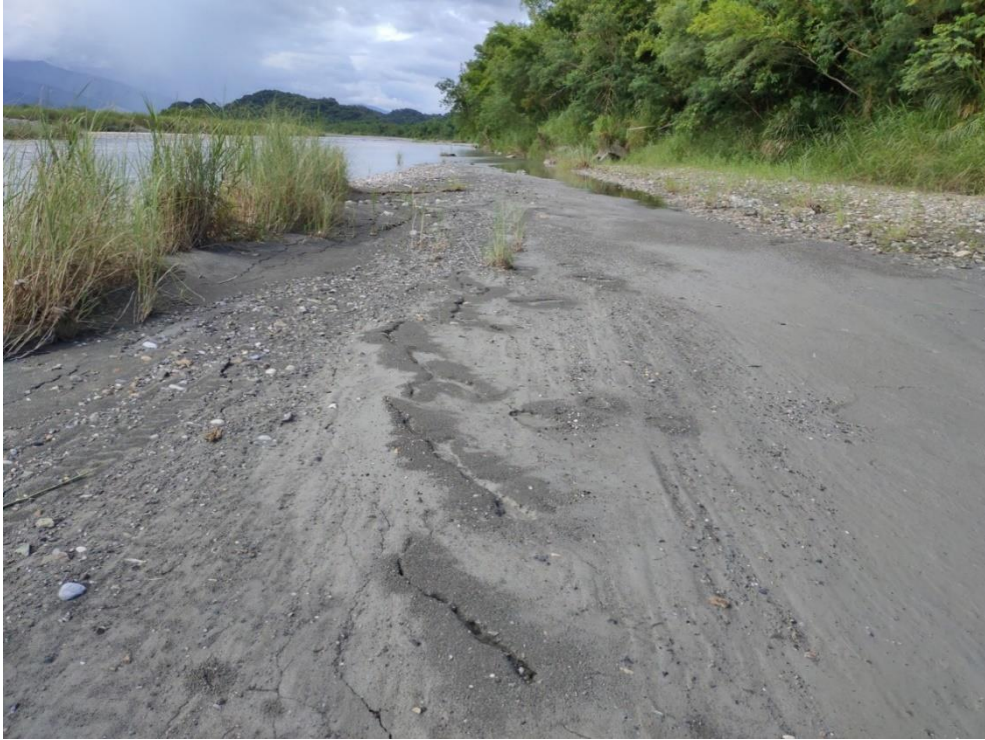
圖 21、山興圳第四支線出口，破裂向 N25°E 方向延伸，呈左移形式雁行排列，部分裂隙與噴沙孔受泥沙覆蓋（劉彥求攝）。
