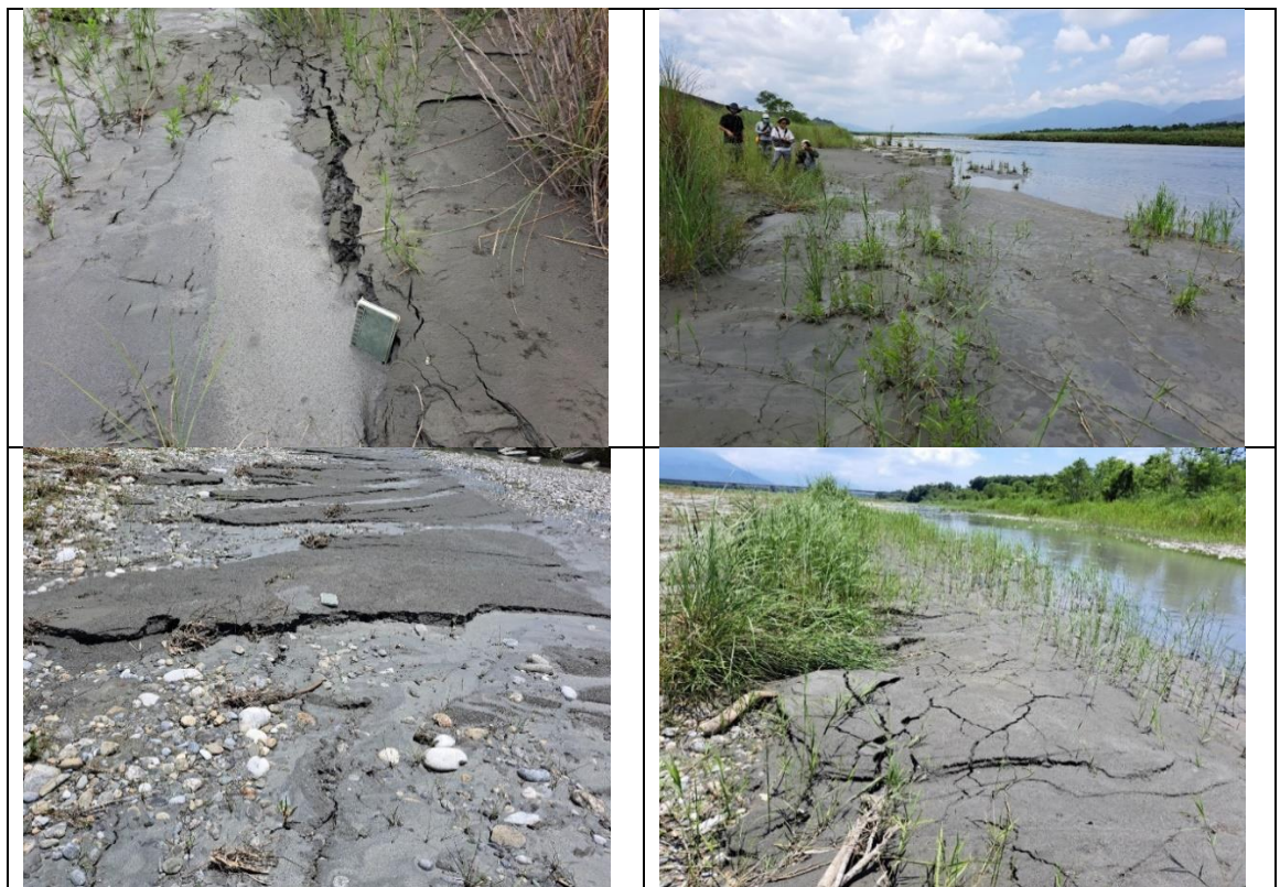
圖 15、花蓮縣鳳林鎮中興大橋南側堤防外，沙洲受擠壓呈現連續拱起破裂與噴沙情形（劉彥求攝）。
