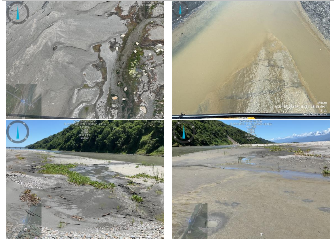
圖 29、花蓮大橋下零星噴沙（上二圖）與木瓜溪口南北兩岸一系列東西向裂隙（下二圖）（黃志遠、梁勝雄攝）。
