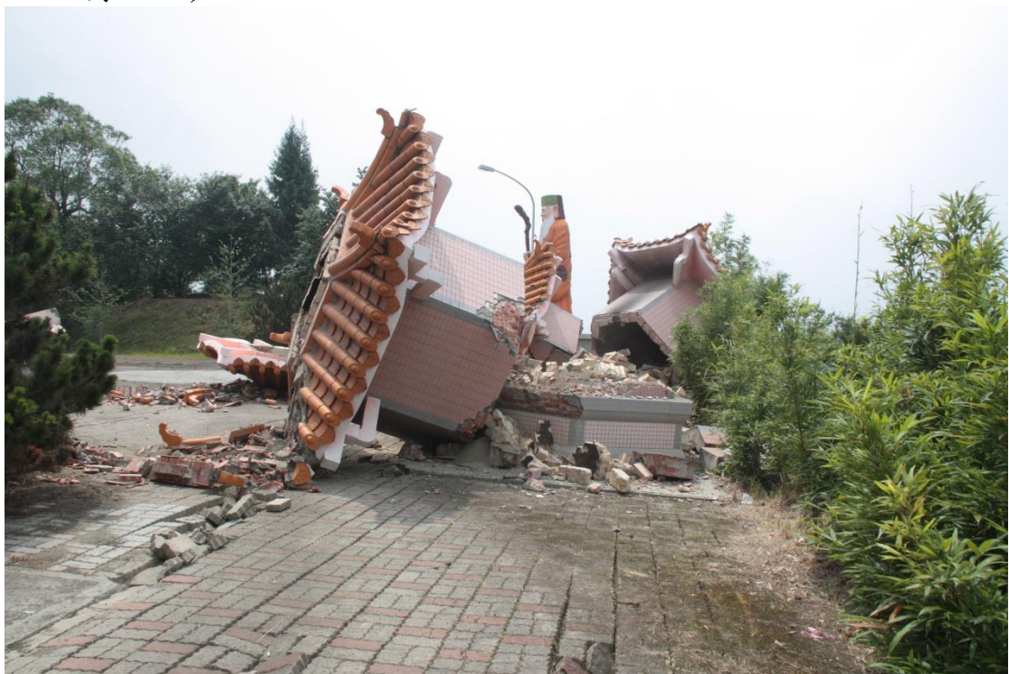
圖十 鹿谷鄉公墓的金爐在本次地震倒塌，此類型之災情屬於地震劇烈搖晃所導致。（攝於 102 年 6 月 4 日）
