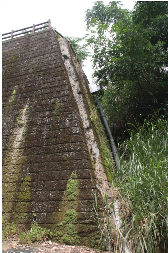
圖八 調查結果顯示鐘樓傾斜之主因應為其附近地基滑動，鐘樓下方的擋土牆已產生位移。（攝於102年6月4日）
