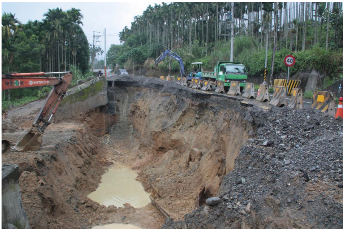
圖十四 本次地震在雲林縣、南投縣及嘉義縣山區均有多處山崩及路基滑動導致交通中斷的災情傳出，本照片為投 131 縣道。（攝於 102 年 6 月 4 日）
