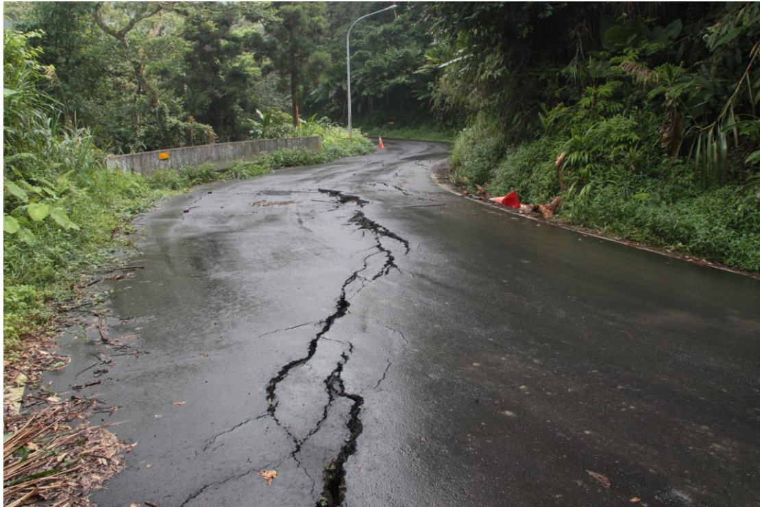
圖十三 鳳凰谷鳥園旁之道路已有明顯路基滑動現象。（攝於 102 年 6 月 4 日）
