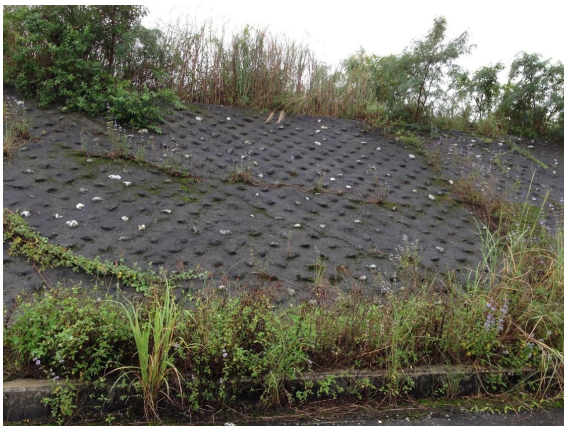
圖 14、點位 6 照片，馬太鞍溪旁堤防。
