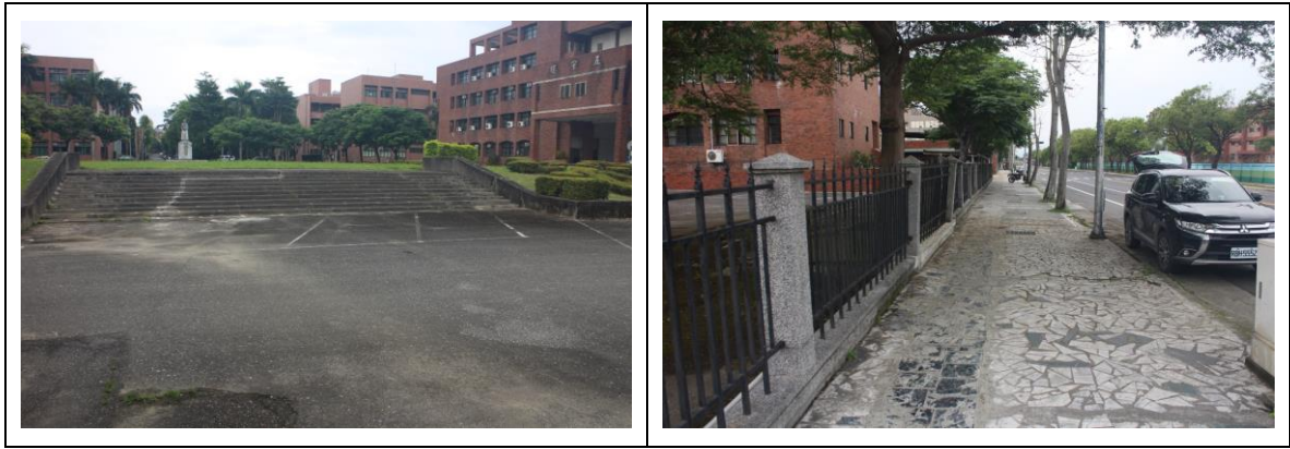
圖 3-3、舊花師校區一帶本次地震後現場狀況。 舊花師校園之地表破裂(左圖)與該校華西路圍牆(右圖)，經修整後本次地震後並未發生破裂。
