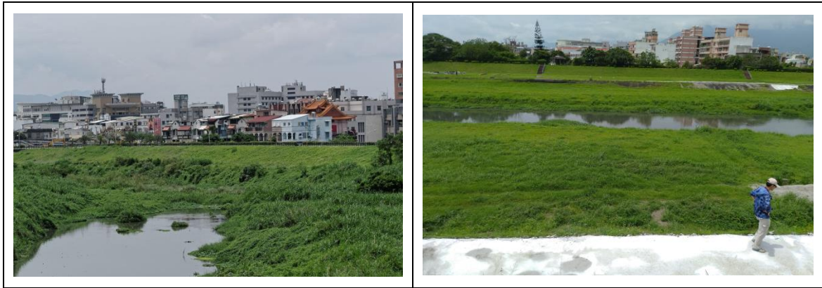
圖 3-5、沿美崙溪兩側巡視過去曾發生液化區域，此次並無液化現象產生。於 2018 年 0206 地震破損後修補完成的河堤並無新增破裂，左圖為三號橋上向南拍攝，右圖為忠烈祠前向西拍攝。
