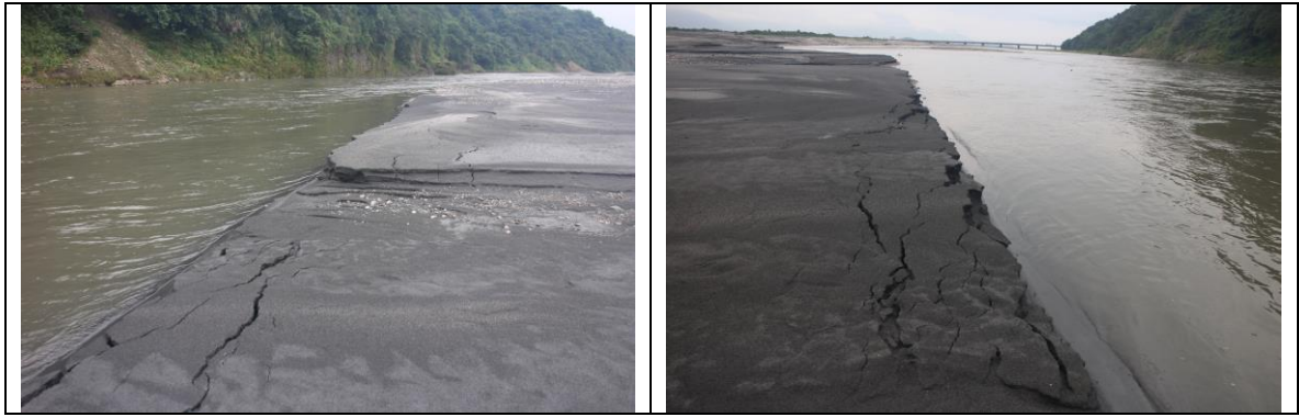
圖 3-13、木瓜溪與花蓮溪匯流處附近出現之側潰現象。
