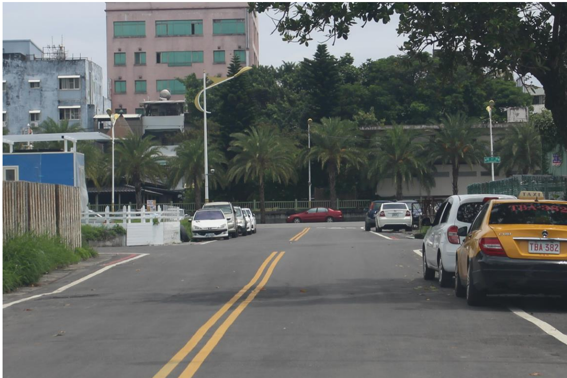
圖 3-6、2018 年 0206 地震地表破裂通過廣東街處現況。2018 年 0206 地震地表破裂跡通過的廣東街處原路面破裂已鋪平，但仍可見到東側略微抬昇的地形特徵。本次地震後該重鋪的路面並無發現破裂。向東拍攝。
