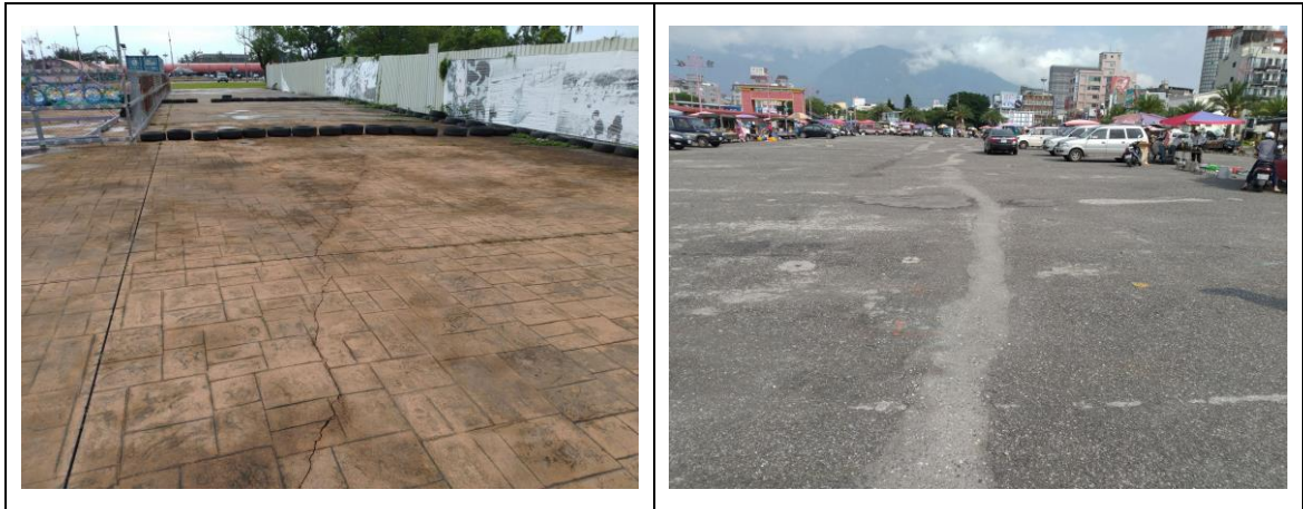
圖 3-7、東大門夜市內 2018 年 0206 地震地表破裂現況。 2018 年 0206 地震後原先在此處不甚連續之破裂逐漸串聯，且兩側落差轉趨明顯而可連續追蹤達 1700 公尺，延伸走向平均約為 N10°W，左圖為夜市最西側一道破裂，向南拍攝；右圖為東側另一道破裂，向北拍攝。
