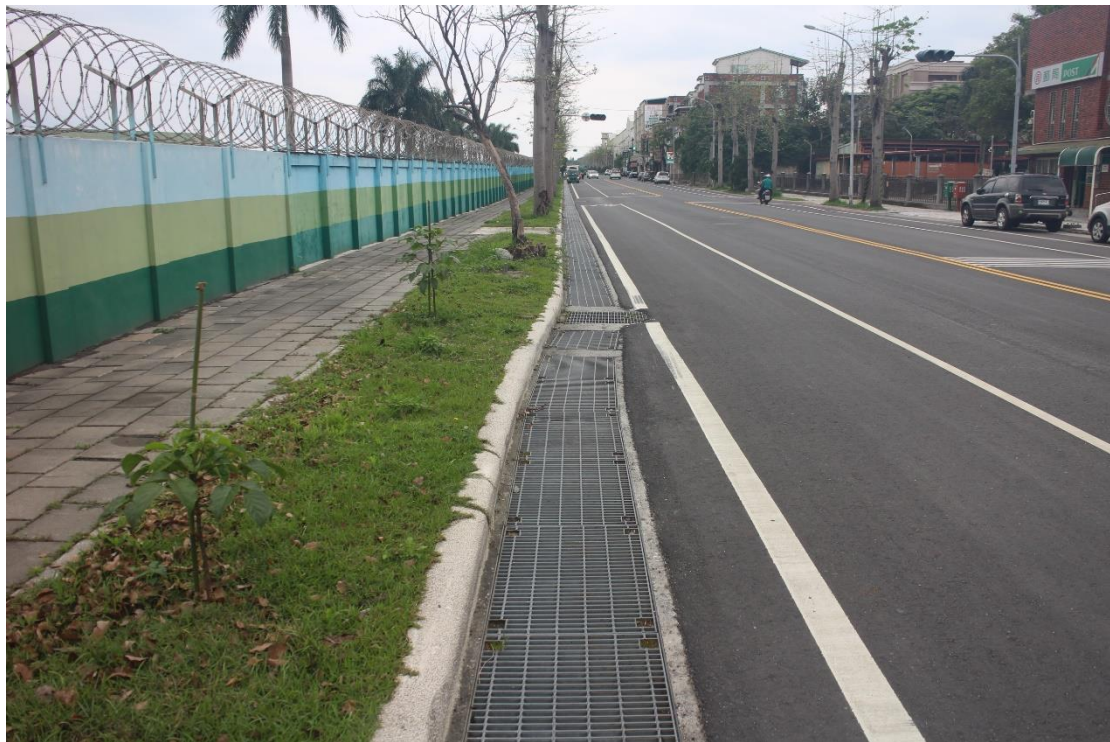
圖 3-4、華西路旁前次震損的圍牆與路面已修復完成，本次地震後亦未破裂。
