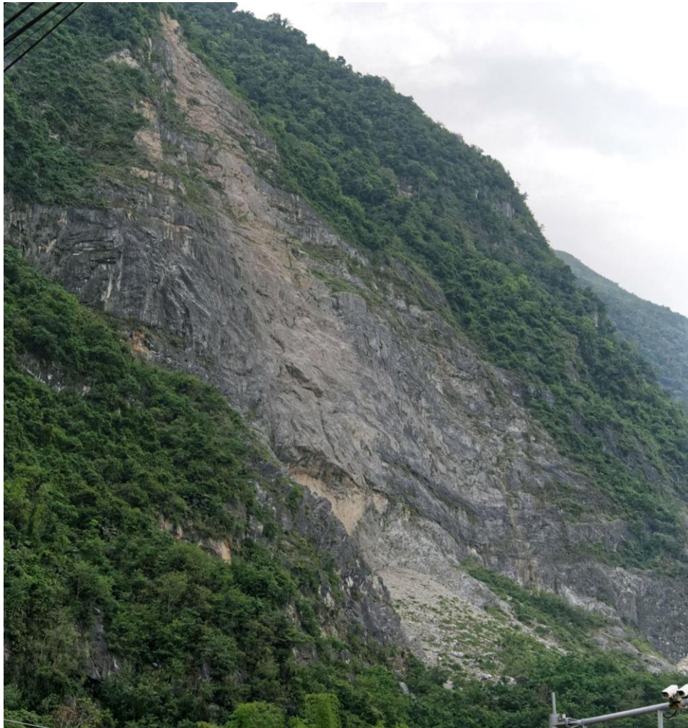
圖 3-17、崇德車站西側，報導主要提到的舊礦場落石，為舊有落石區域，向西拍攝。
