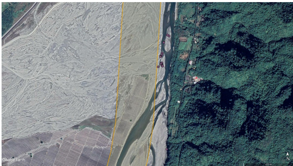
圖 18、點位 4 米棧北側沙洲液化現象區域，約朝 N0-10E 延伸至少 270 公尺，但範圍應遠大於此，因受河流限制無法涉渡確認，此區域液化程度為此次調查點為中最大者。
