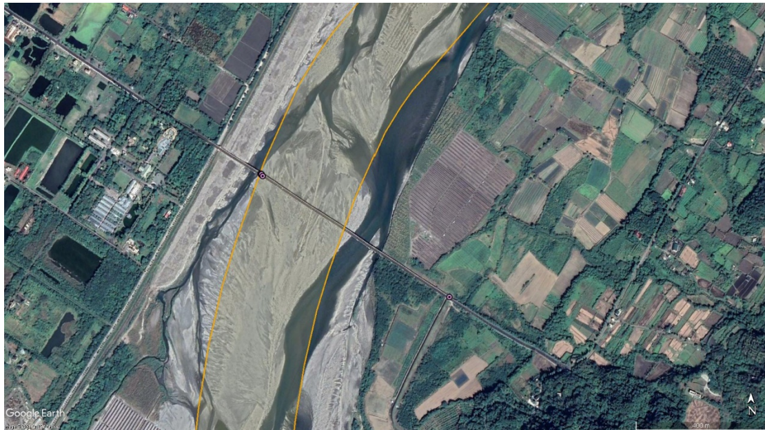
圖 21、點位 5 米棧大橋僅見輕微液化（西側點位）與既有橋梁結構裂縫擴大（東側點位）
