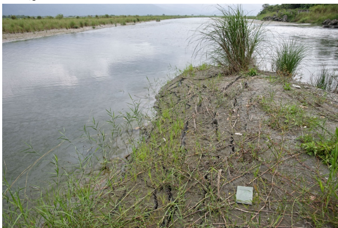
圖 16、點位 3 米棧南側沙洲最北端，細沙泥混合鬆軟沉積物發生側潰，表層出現薄皮狀的伸張裂隙，朝北拍攝。
