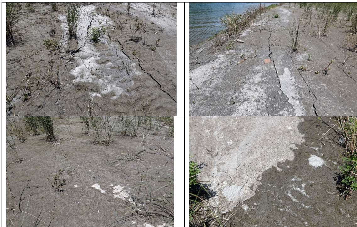
圖 14、點位 2 中興橋東北側沙洲液化側潰，大致平行河岸，沿 N60-70E 方向延伸至少 200 公尺長，液化現象在礫石含量增高到接近顆粒支持處消失。
