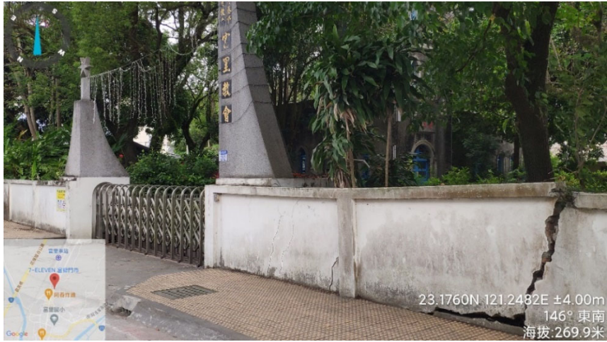
圖 13、富里鄉中山路富禮教堂圍牆及周圍地區有多處破裂及錯移現象。
