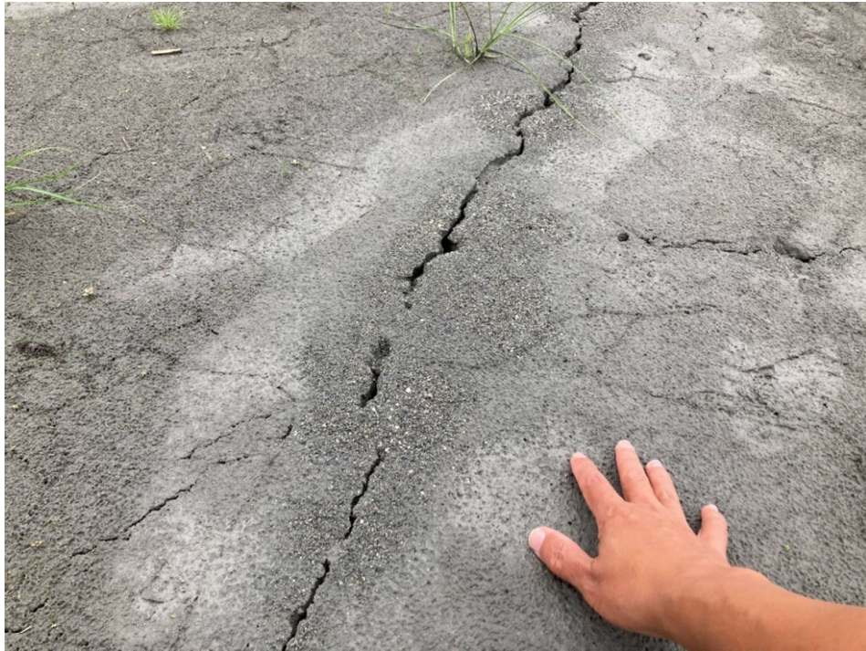
圖 25、玉里大橋下具小規模液化噴砂現象。
