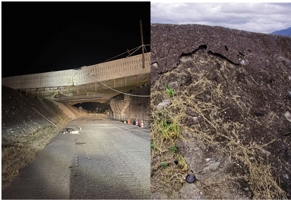
圖 31、玉興橋與側翻預力橋梁（旺財應用地質技師事務所提供），鄰近玉興橋的南側堤防受擠壓鼓起破裂。
