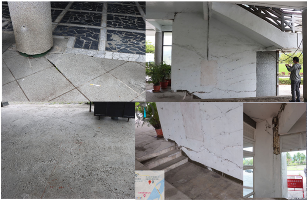
圖 20、瑞穗斷層跡附近，僅秀姑巒溪遊客中心人工建築物有結構破壞、地面磁磚拱裂現象。
