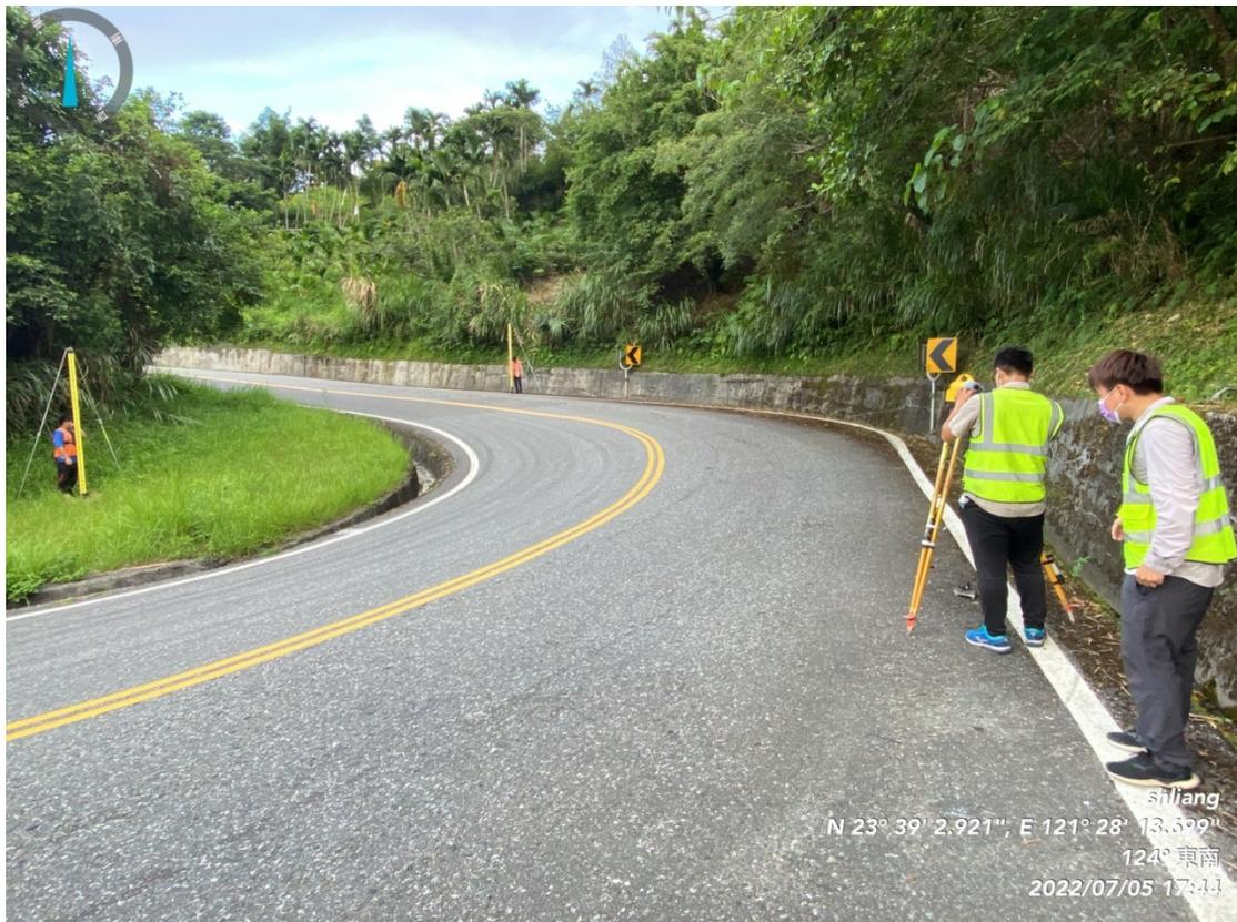
圖 1、0620 地震後，本所於野外水準測量工作實例。水準測量為藉由求得兩標尺間的高度差，進而求取整段施測路線的總高度差值。
