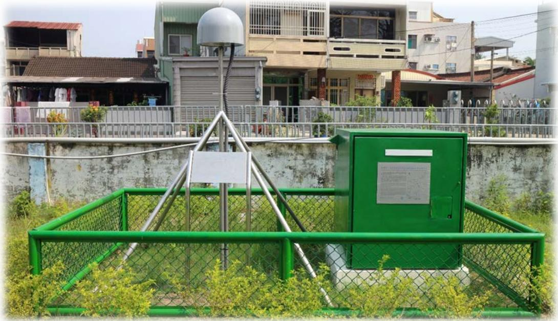
圖 6、GNSS 連續追蹤站外觀，灰色天線罩內為天線所在位置，隨時接收衛星訊號，即時透過網路將觀測資料傳至控制室處理與解算。
