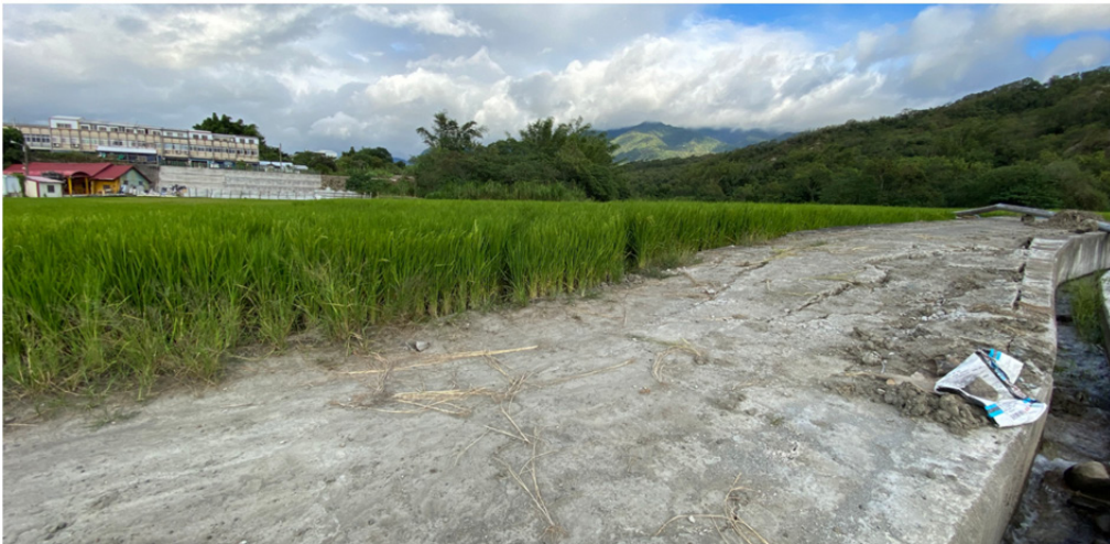
圖 6 池上斷層露頭。A：富里鄉富池橋附近，利吉層逆衝至接地礫石層之上。B：2022 年 0918 池上地震，富里鄉富池橋北側農路池上斷層產生地表破裂與隆起。
